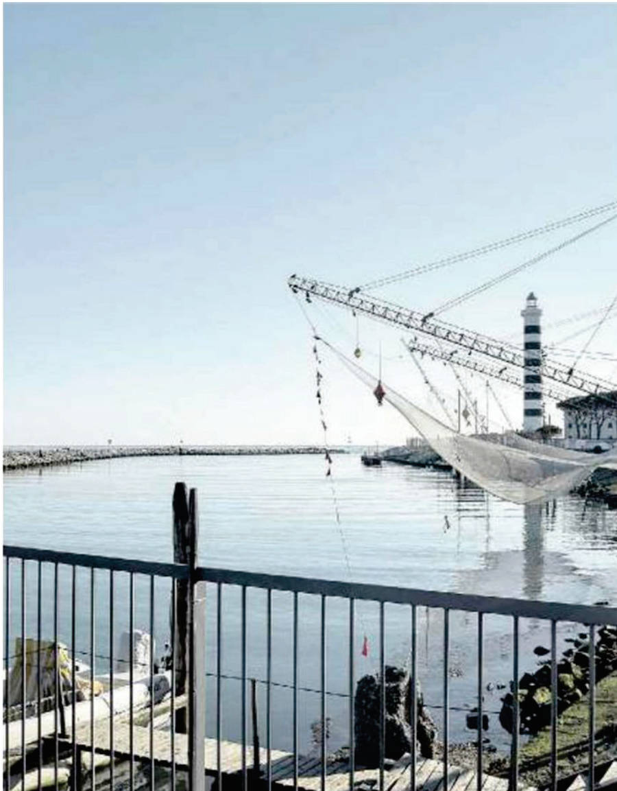
SCAMBIO La foce del Sile in laguna. Da qui verrà iniettata acqua dolce per contrastare la salinità
