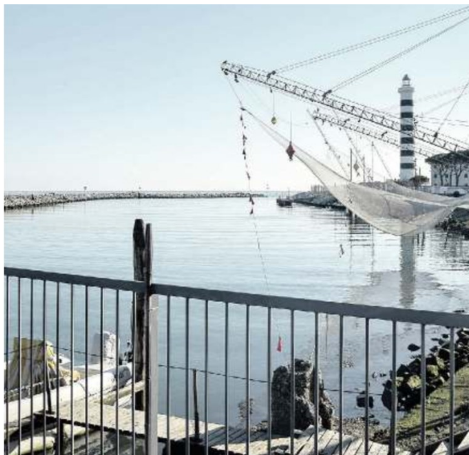
SCAMBIO La foce del Sile in laguna. Da qui verrà iniettata acqua dolce per contrastare la salinità
