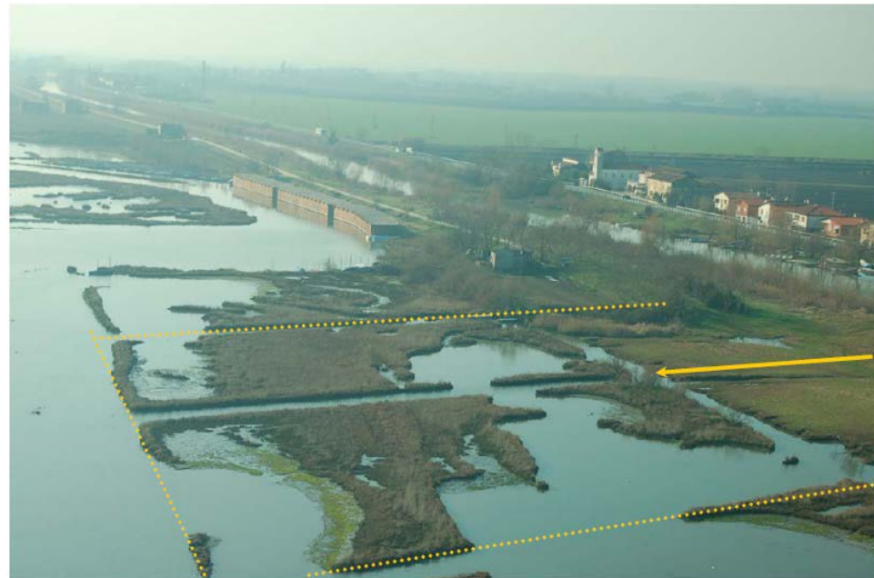
Veduta aerea dell'area di intervento con indicazione del punto di sbocco
