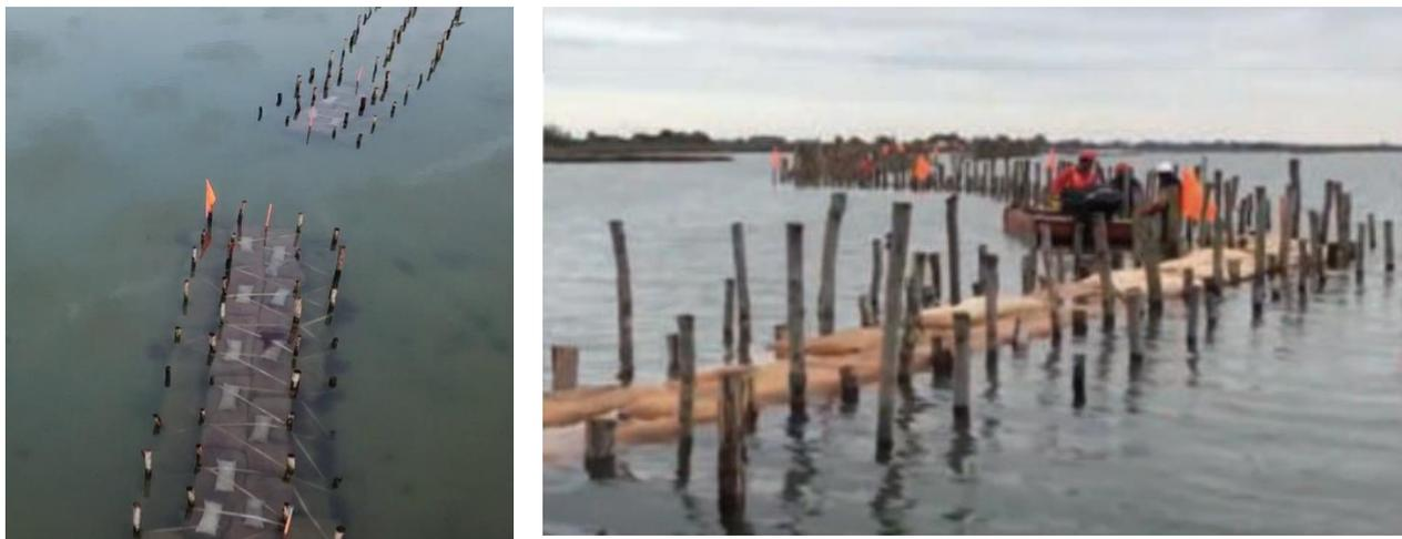
Figura 4. Dettaglio delle strutture morfologiche realizzate tramite la messa in opera di materassi in fibra di cocco e juta.
