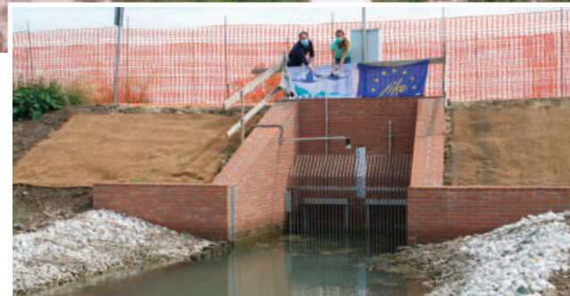
Inaugurazione dell'apertura della canaletta: maggio 2020 Inauguration of the channel opening: May 2020
