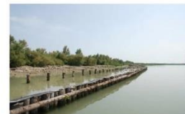
TRATTO DI PALIFICATA GIA' REALIZZATA LATO LAGUNA
