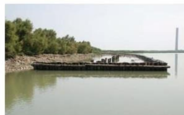
TRATTO DI PALIFICATA GIA' REALIZZATA LATO NORD
